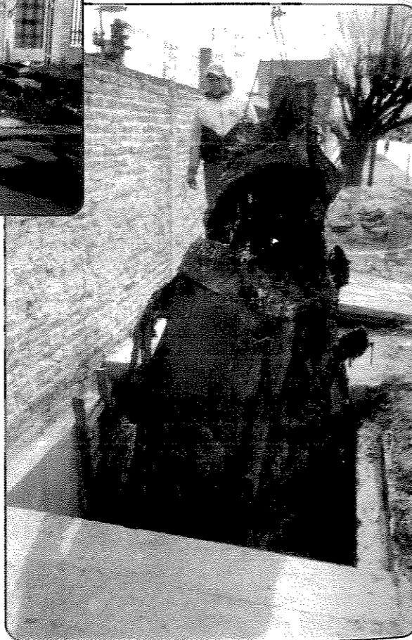
Imágenes de la extracción de autopartes en la cámara de inspección en el conducto de Las Perdices del Partido de Lanús.
